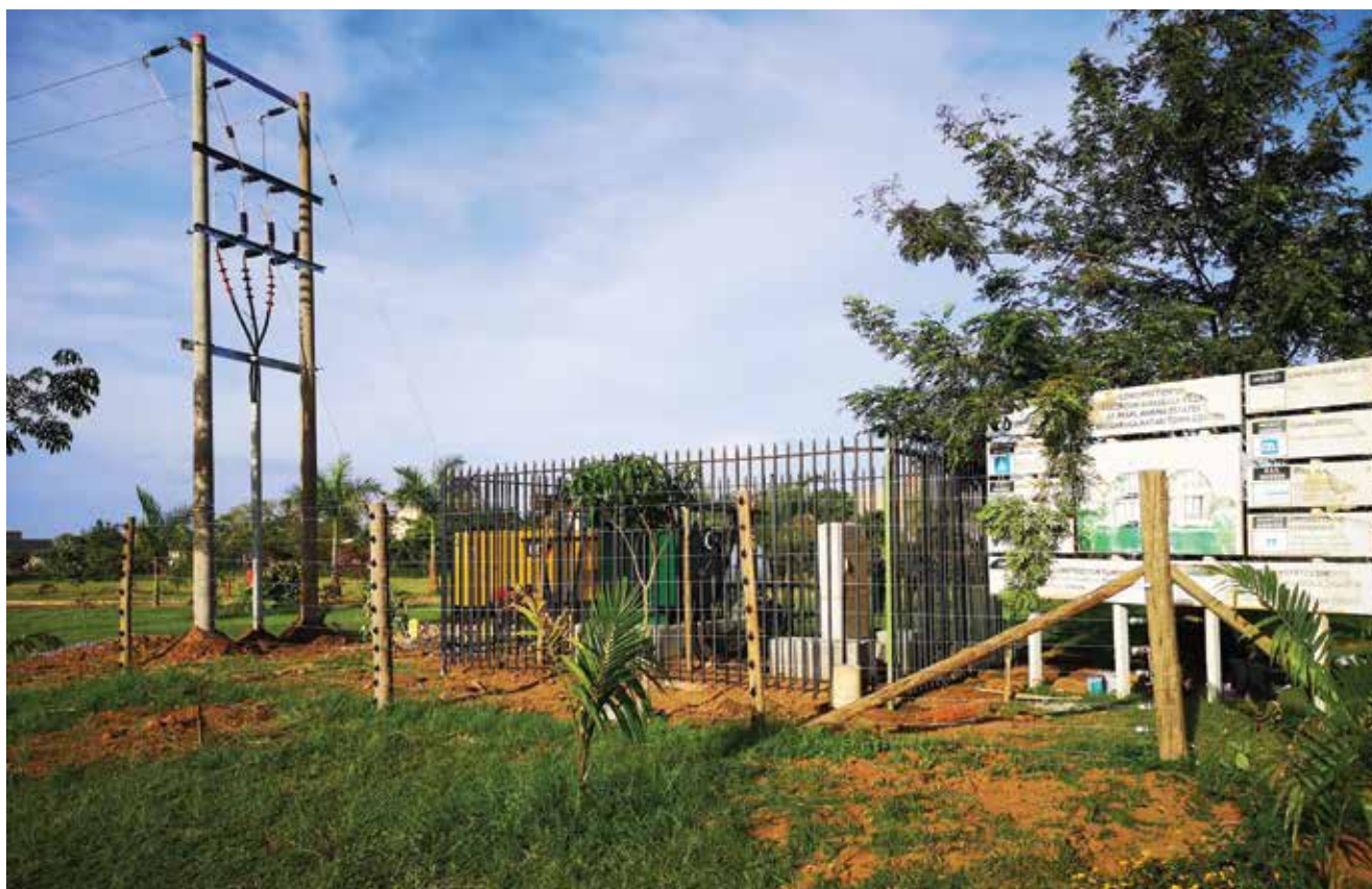
33kv Mini Sub-station
